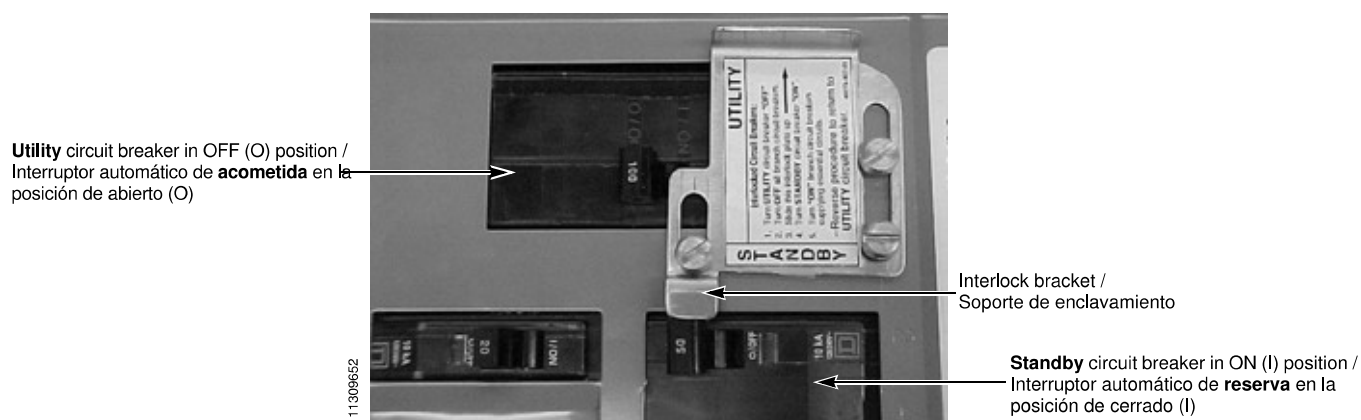
Figure / Figura 4: Utility Circuit Breaker in OFF (O) Position / Interruptor automático de acometida en la posición de abierto (O)
